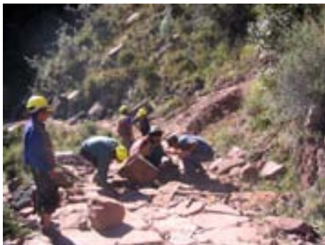
Fig. 19. Comunarios de Chaunaca empadrandando la calzada.
