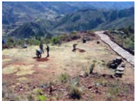
Fig. 18. Ejecución de pozos de sondeo en área de descanso.
