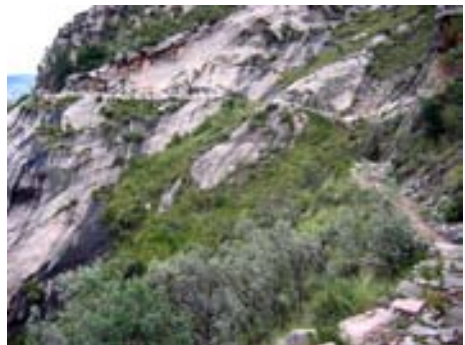
Fig. 8. Corte de la roca para la construcción del camino.
