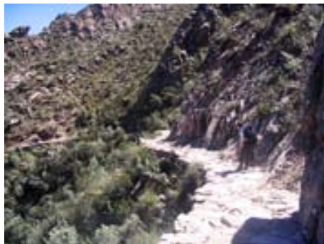
Fig. 20. Segmento de camino en óptimas condiciones transitables.
