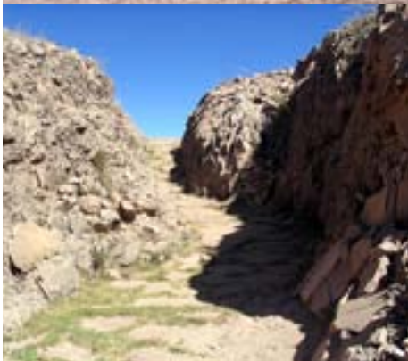
Fig. 10 A y B. Inicio del tramo intervenido.
