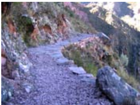
Fig. 21. Capa de cascajillo dispuesto sobre plataforma rocosa.
